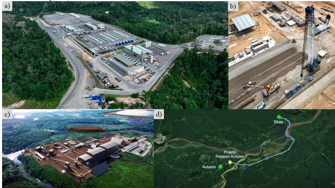
Figura 9. Plantas industriais: a) planta do Azulão; b) planta Azulão 950 e obras; c) projeto de construção da área industrial de beneficiamento da silvinita e sua transformação em potássio; d) linha de transmissão entre Silves e a área industrial de mineração de silvinita no município de Autazes. Org. os autores. Fonte: Eneva; Potássio do Brasil.
