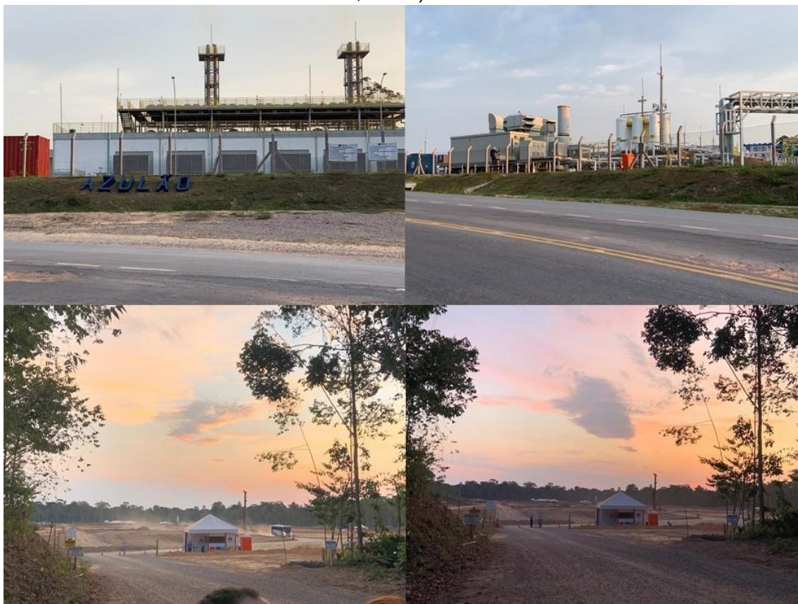
Figura 8. Planta industrial do Azulão em operação e área de construção do complexo Azulão 950. Fonte: Emily Venâncio, 2023.
