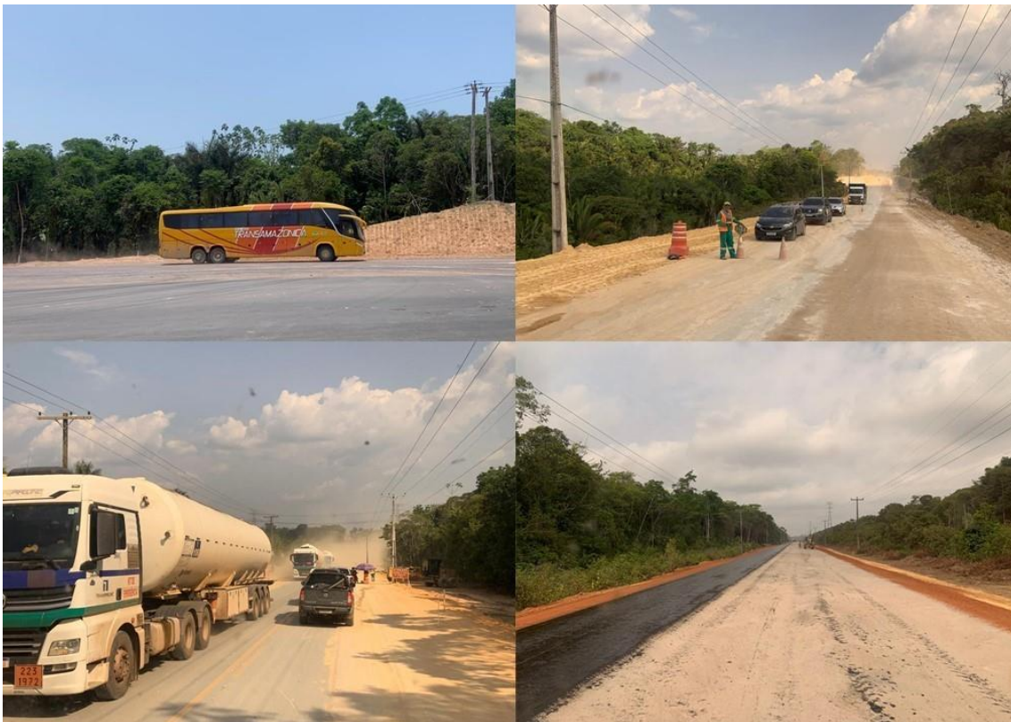
Figura 3. Obras na rodovia AM-010: a) ônibus da linha Itacoatiara-Manaus; b) obras de manutenção; c) fluxo de carretas transportando GNL de Silves (AM) para Boa Vista (RR); d) obras de pavimentação. Fonte: Emily Venâncio, 2023.
