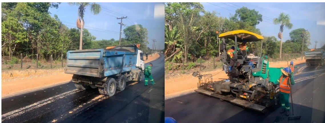
Figura 2. Rodovia recebendo nova camada asfáltica. Fonte: Emily Venâncio, 2023.
