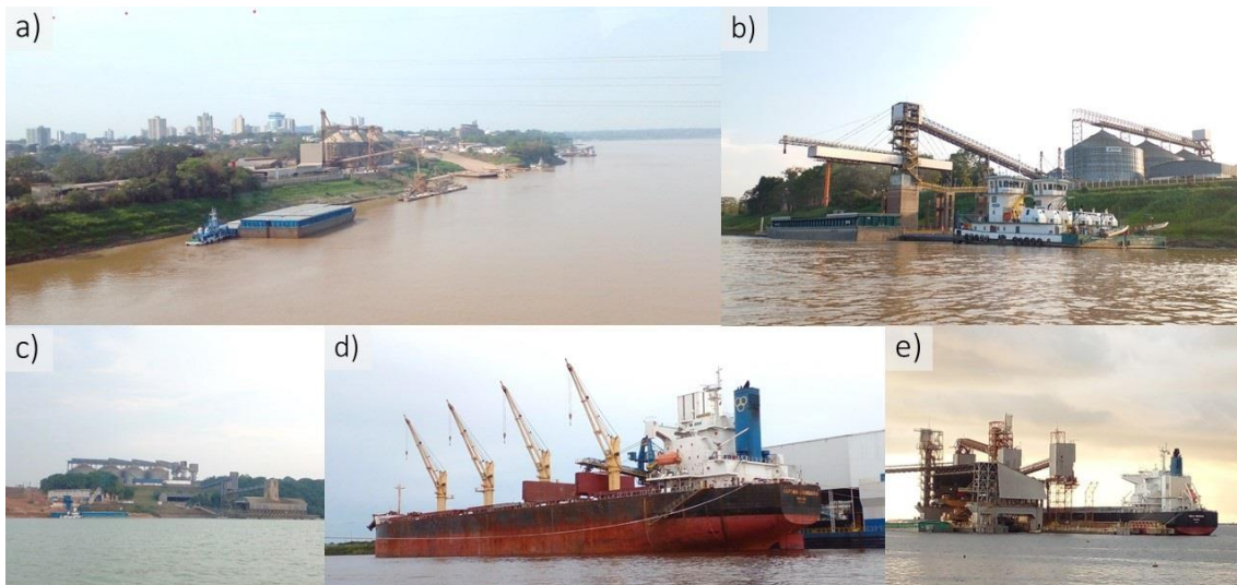
Figura 1. Portos fluviais: a) portos e barcaça para o carregamento de grãos em Porto Velho; b) porto graneleiro em Humaitá; c) porto em Itaituba; d) porto em Novo Remanso, no município de Itacoatiara; e) porto da Cargill em Santarém. Imagens do autor entre os anos de 2022 e 2023.
