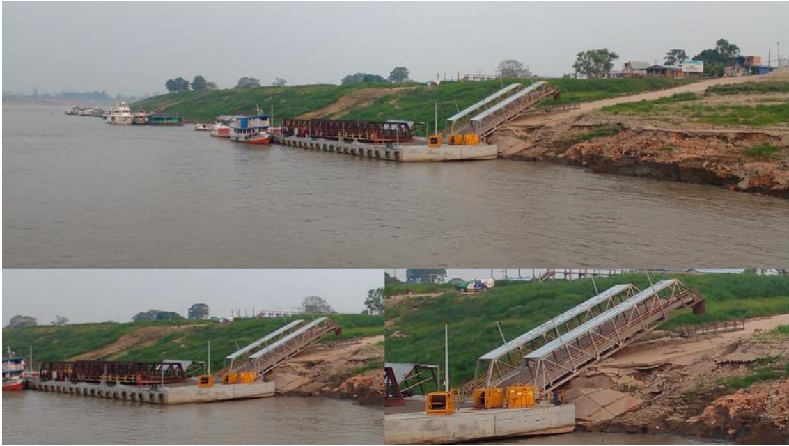
Figura 7. Porto do Careiro da Várzea: a) área do porto; b) e c) área comprometida pela vazante do rio. Imagens do autor em novembro de 2023.
