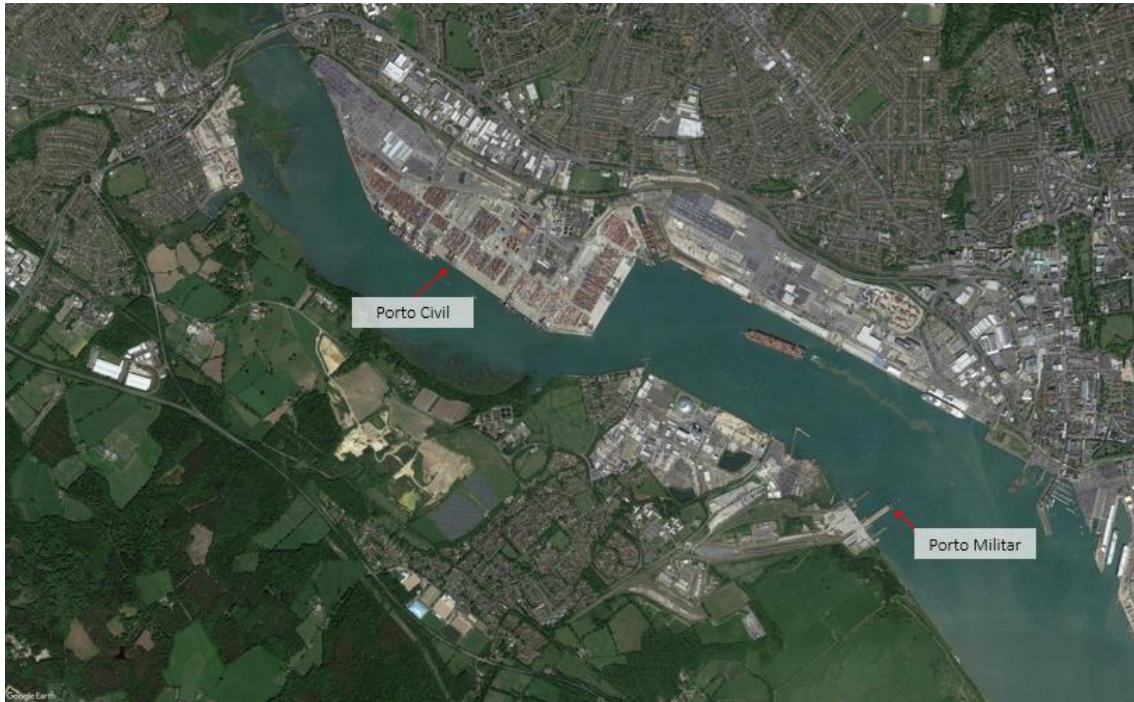
Figura 4. Porto Militar de Marchwood e as demais estruturas portuárias para o transporte de cargas e passageiros da cidade de Southampton situado no sul Inglaterra. Fonte: Google Earth, org: Thiago O. Neto.
