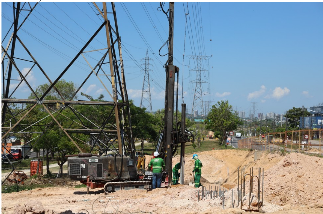
Figura 1 – Obras de implantação da Avenida das Torres sob a área de transmissão do Linhão de Tucuruí, em Manaus
