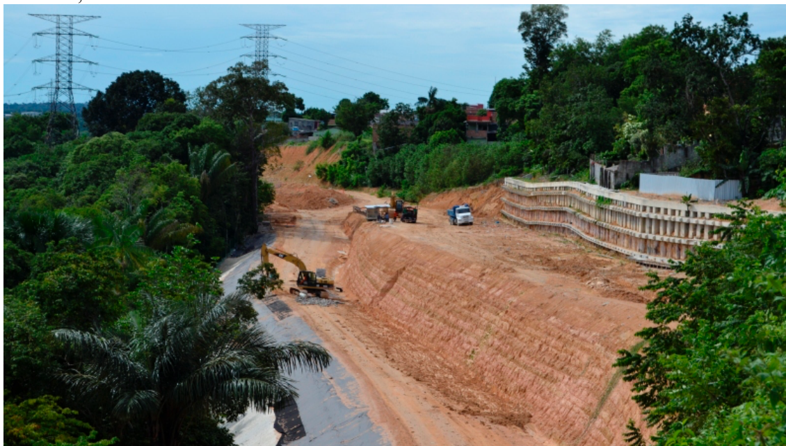
Figura 2 – Construção da Avenida das Torres no trecho próximo à passagem de nível da Avenida Timbiras, em Manaus
