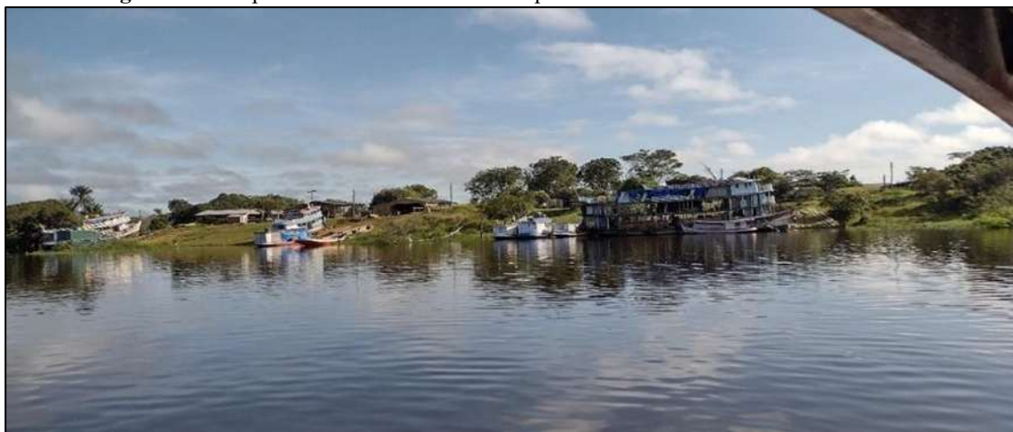
Figura 3: Vista panorâmica dos estaleiros no polo de Sebastiao do Uatumã /AM
