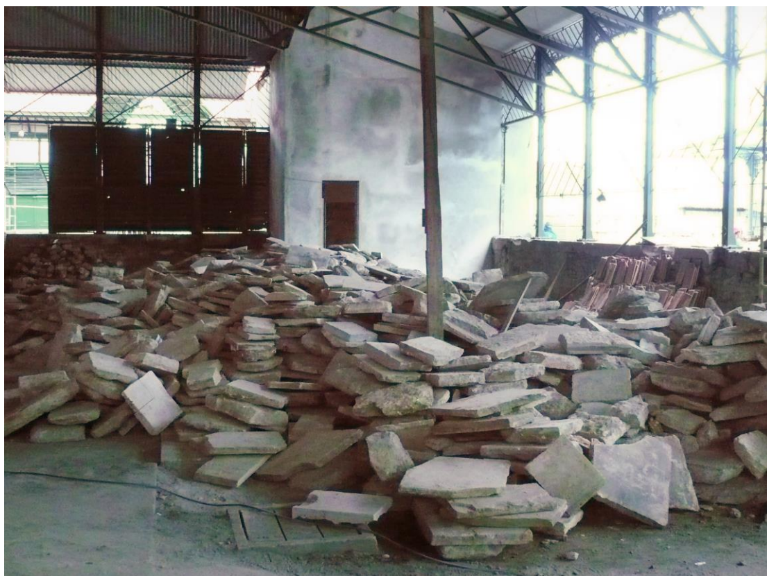
Figura 15: Blocos de pedra de lioz retirados do piso para recuperação e reassentamento
