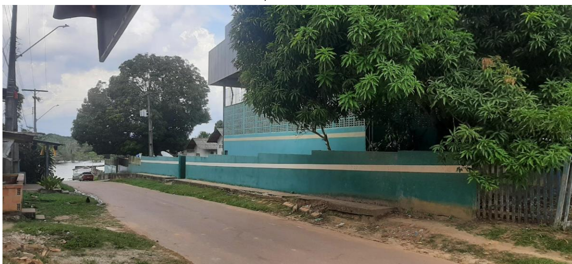
Figura 2 – Escola Municipal José Sobreira do Nascimento, Comunidade Nossa Senhora de Fátima, Manaus-AM.
